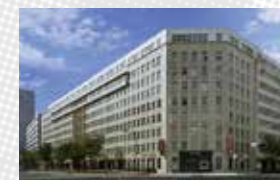
増築後の鉄鋼ビルディング全景
