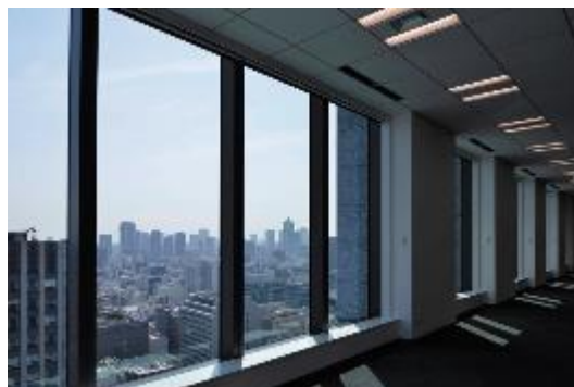
Low-E 複層ガラス、重力式換気システム（エコレーター）
